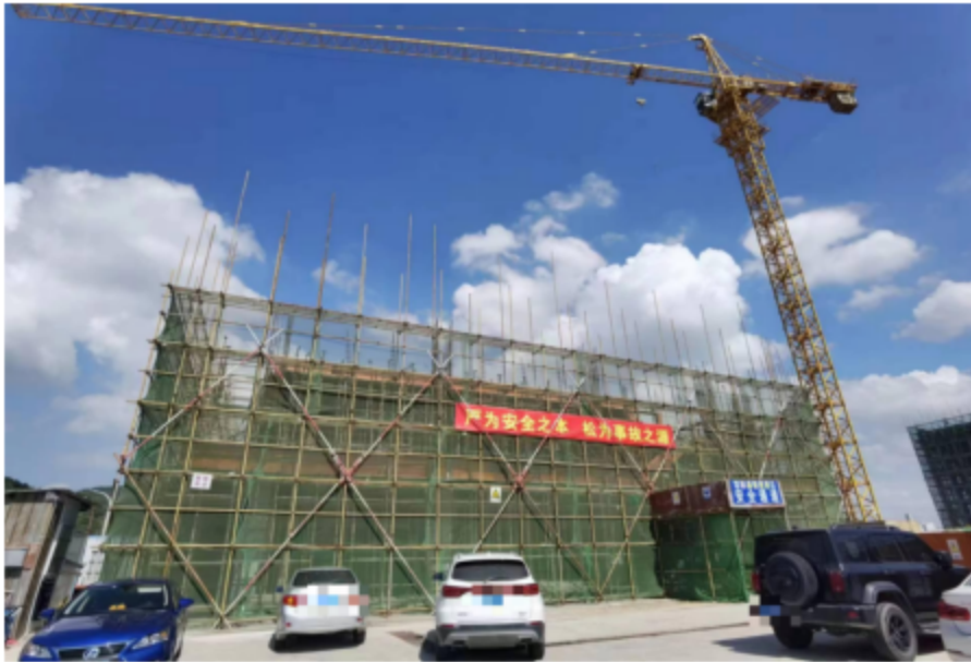
图2 工地在建3号楼
